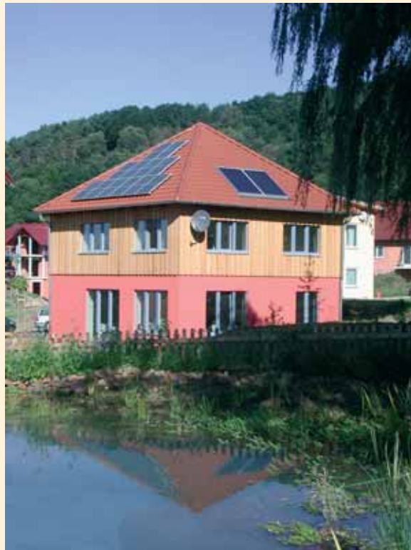
Einfamilienhaus mit Photovoltaik- und Solaranlage in Cölbe Quelle: wagner-solar.com
